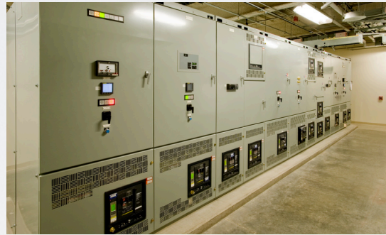
Cung cấp, lắp đặt tủ điện công nghiệp, điện tự động
