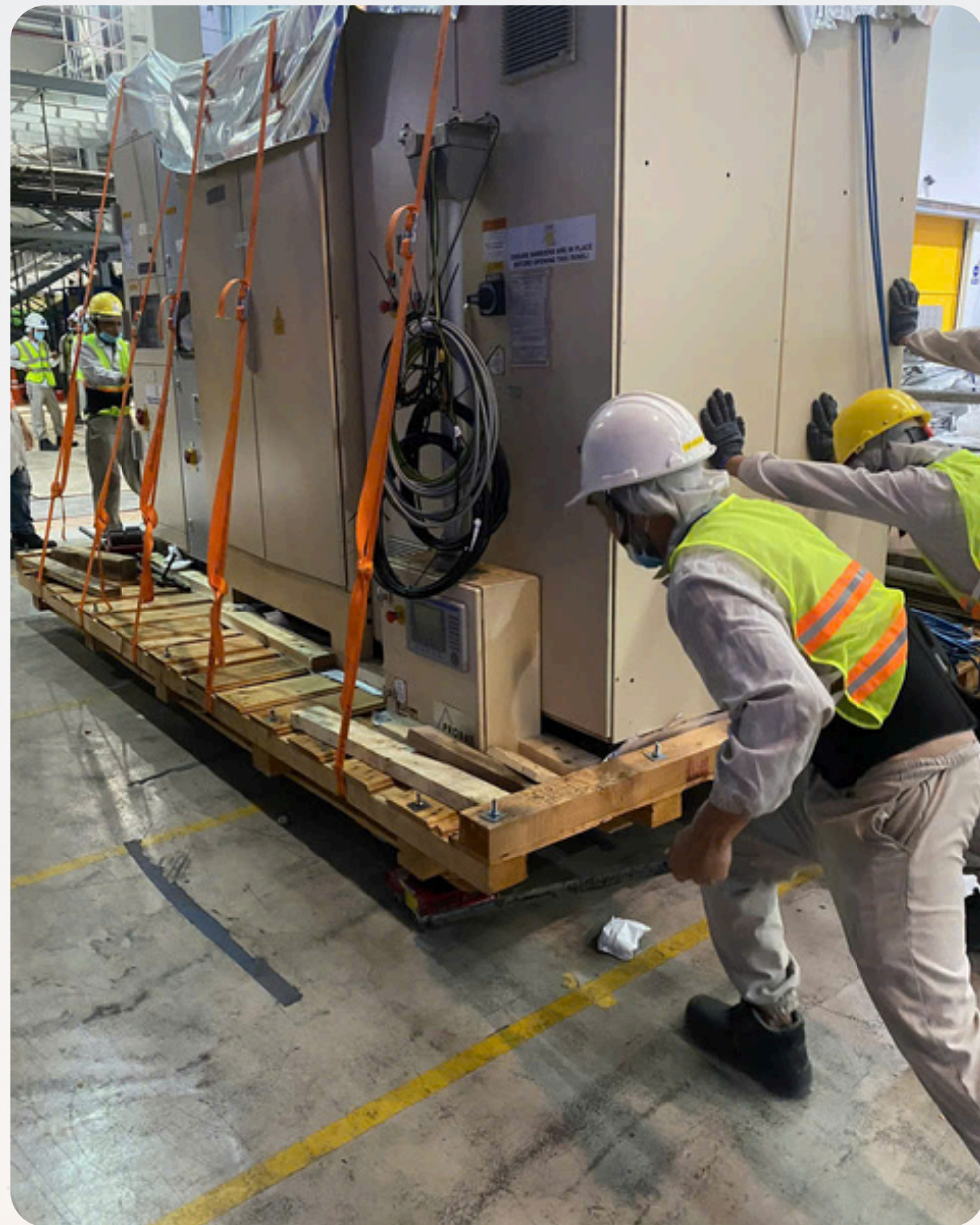
Thi công hệ thống tủ điện khu chế biến
