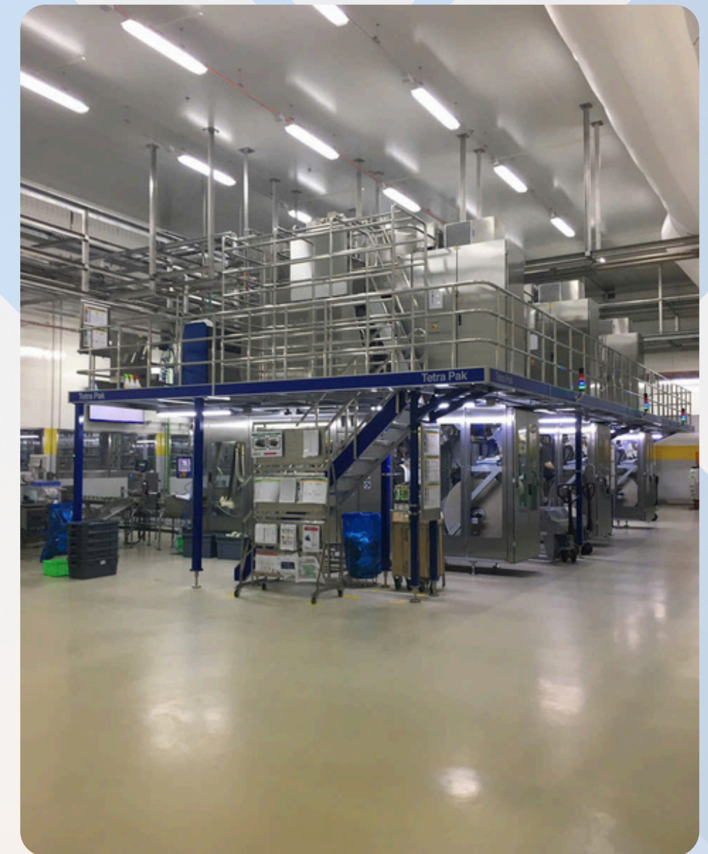
Thi công hệ thống đèn chiếu sáng phòng sạch
