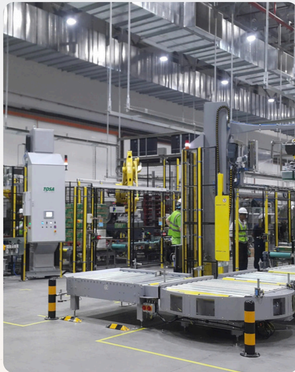
Thi công dây chuyền robot đóng gói tự động
