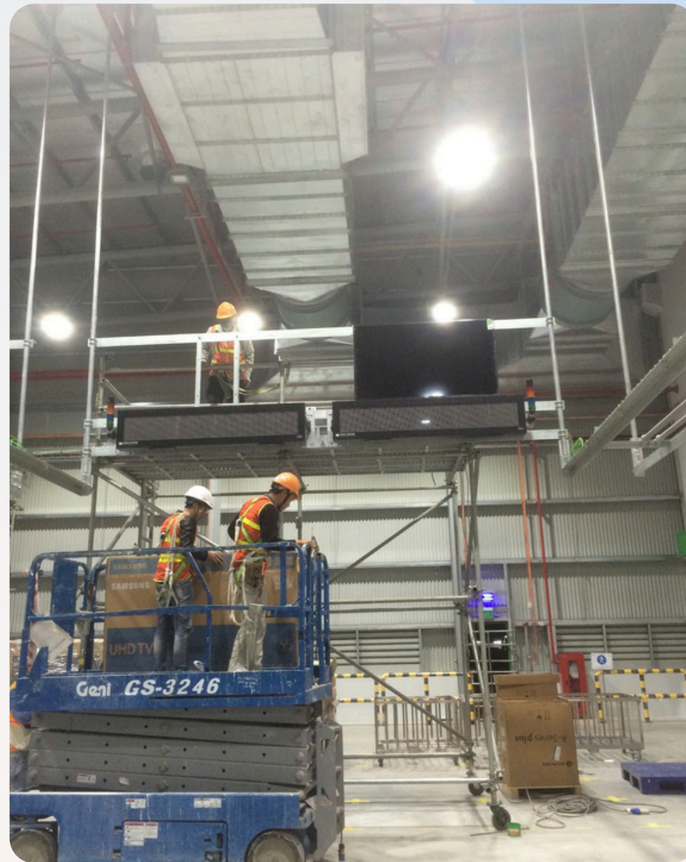
Thi công lắp đặt tivi, bảng led dây chuyền đóng gói
