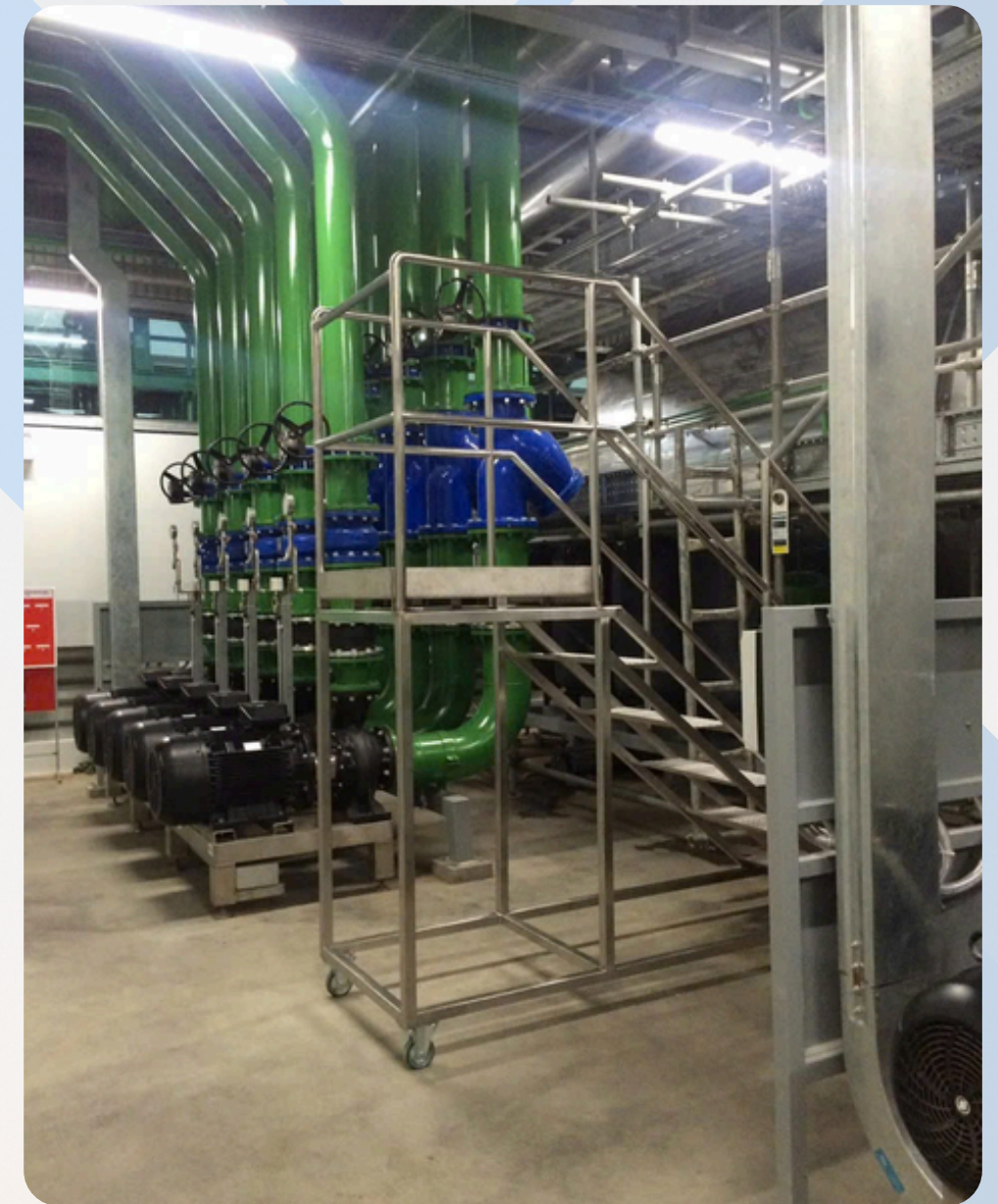
Thi công lắp đặt sửa chữa máy lạnh công nghiệp và dân dụng
